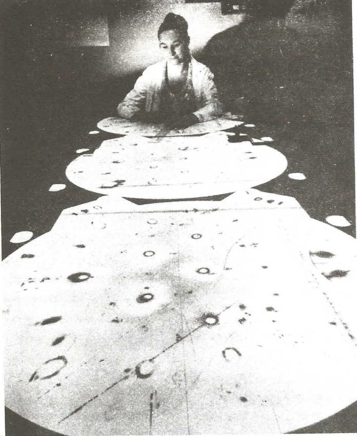
Las interacciones entre partículas se han deducido estudiando las trazas que dejan, cuando tienen carga eléctrica, en una cámara de burbujas
