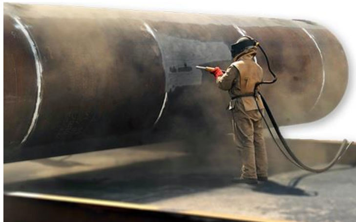
Figura 1.- Fotografía del proceso de arenado para quitar el recubrimiento de una tubería.
